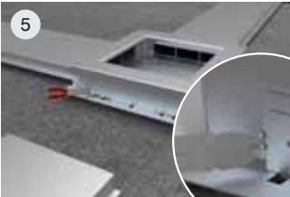
Kanal ölçüsüne göre seperatör sacını kesiniz.
