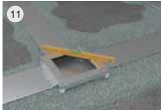
Tesviye şapını atınız. Kanal ve Buatların altında hiçbir boşluk kalmayacak şekilde doldurunuz.
