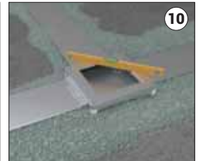
10 Tesviye şapını atınız. Buat ve kanal altındaki boşlukları tam olarak doldurunuz.
