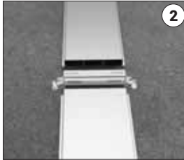
2 Kanalları birbirine ekleyiniz.
